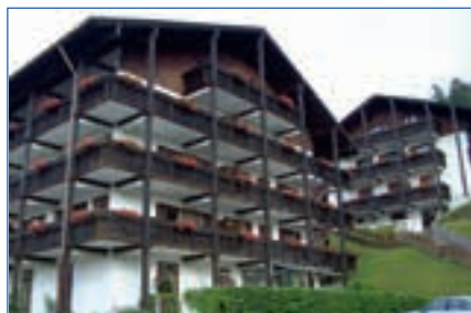
2- Zimmer-Eigentumswohnung in Buchenhöhe
