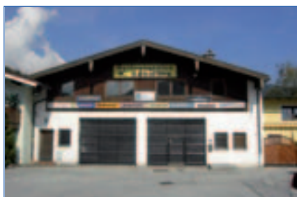
Gewerbliche Halle mit Büro- räumen in Berchtesgaden (Jetzt Mehrgenerationenhaus der Marktgemeinde Berchtesgaden)
